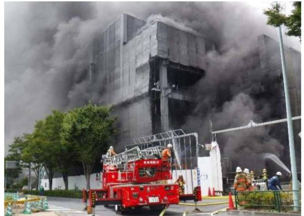
断熱材に引火した火災の例
