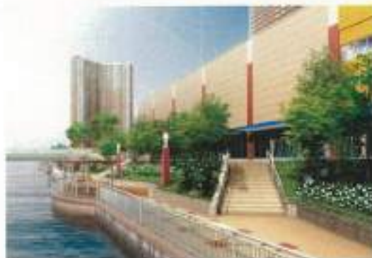
一体的に整備された護岸の遊歩道
