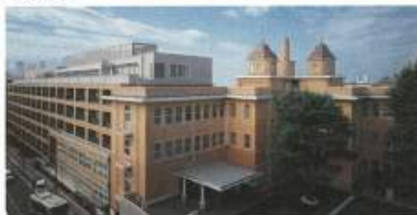
修繕事例 聖母病院
