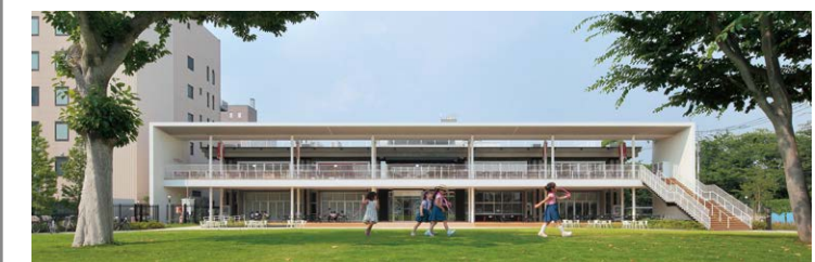
Tachikawa Kinder-Zukunftszentrum Das ehemalige Rathaus wurde in eine lebendige Einrichtung für Kinder umgewandelt.
