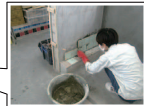
コンクリートパネルを用いたタイル施工実習
