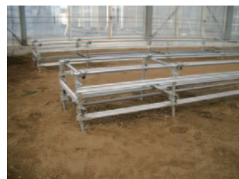
市販のパイプでフレームを組むことにより簡単に設置
