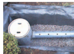
浸透トレンチ
