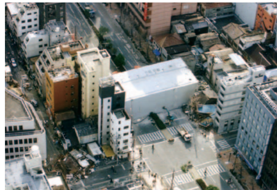
道路上に建物が倒壊し、道路を塞いでいる様子
