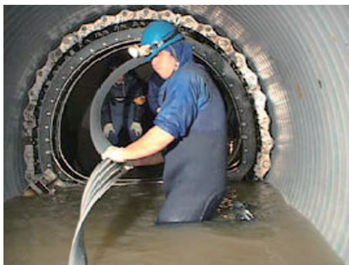
円形断面の施工状況
