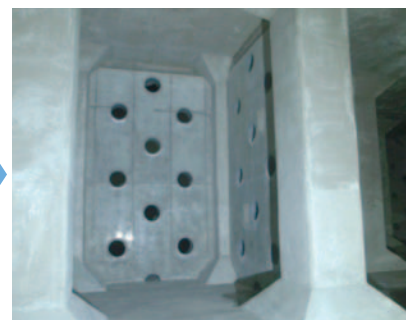
耐震補強後（耐震壁設置）
