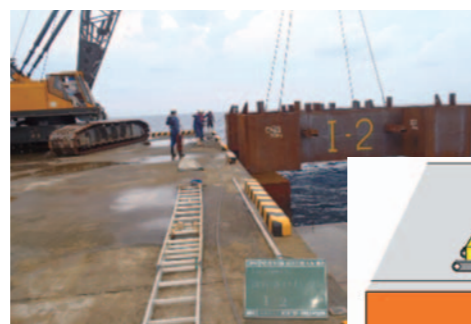
鋼枠据付状況
