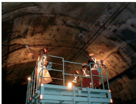
トンネル内の打音調査状況
