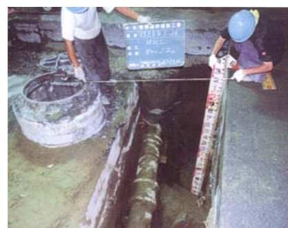
レーダーで発見された空洞の開削調査
