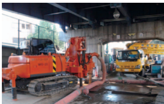
増し杭の打設
