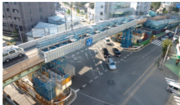
上部工（桁）の取替
