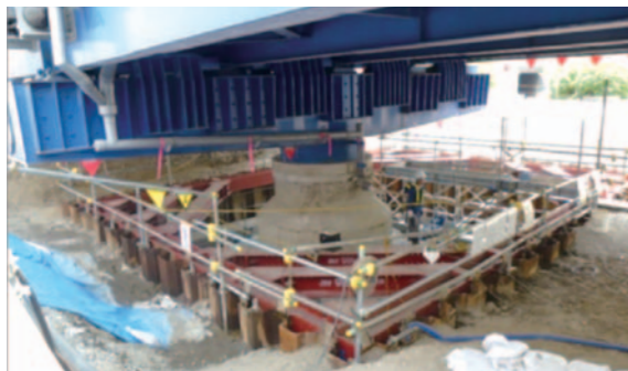
基礎（フーチング）の補強
