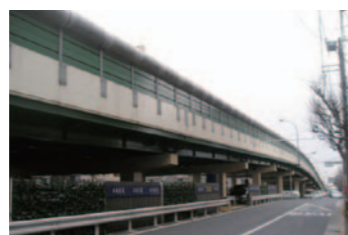
大和陸橋 (1964 年完成)
