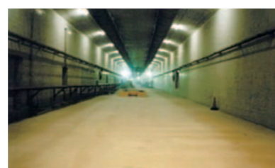
沈設後の 函体内部
