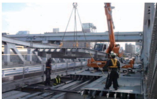
床版の取替（RC→鋼）
