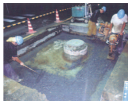
発見された空洞の復旧
