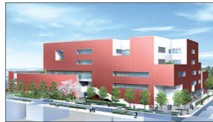
城東職業能力開発センター
