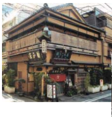
いせ源本館 1930(昭和5)年建築
