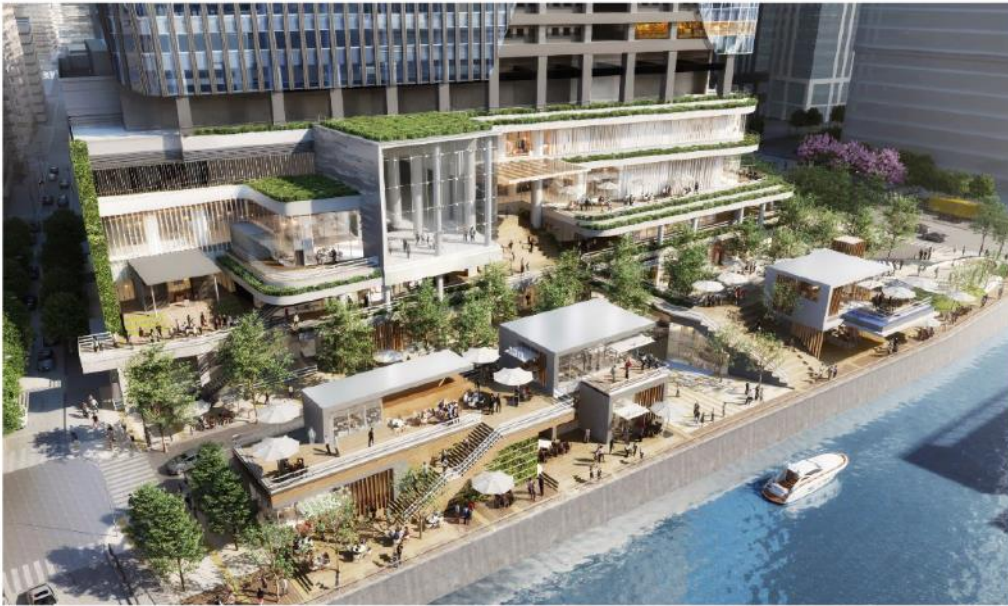
日本橋や日本橋川を見渡す立体広場
