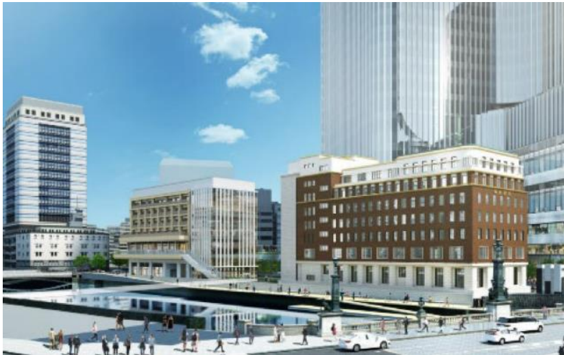
日本橋野村ビル旧館
