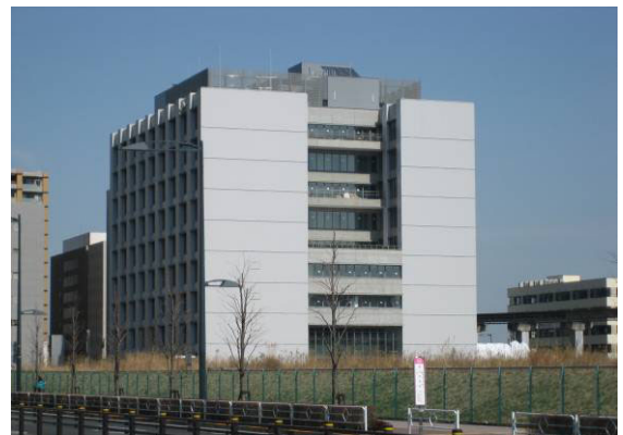
立川第二法務総合庁舎
