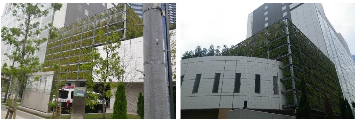
地面から人工地盤までの外壁にツタ状の植栽で壁面緑化を行っている。
