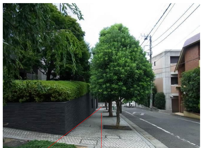
有効幅員不足 (1m 未満)
