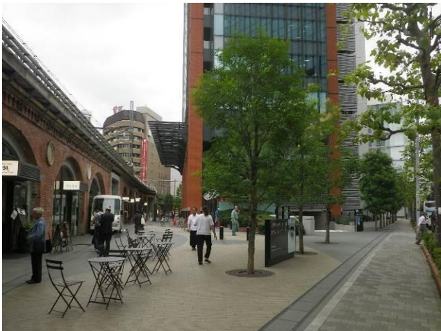
線路下歩行空間 | 道路側歩道
