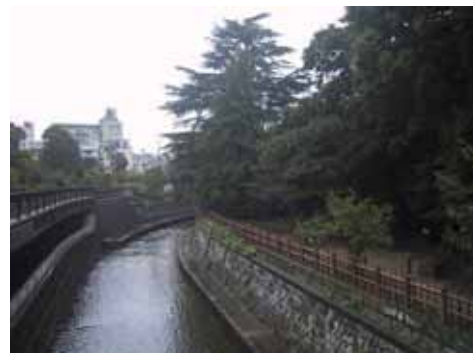
公園と河川による良好な環境 写真左側は、洪水時の調節池流入口 (野方公園、妙正寺川：中野区)
