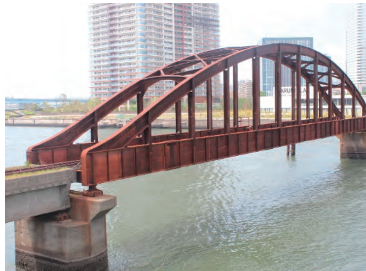
旧晴海鉄道橋の遊歩道への利用転換など、土木遺構の維持保全・活用により、まちと歴史が調和した良好な景観の創出を推進 A
