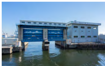
水門・排水機場
