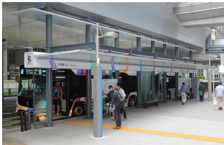
東京BRT新橋停留施設と連節車両
