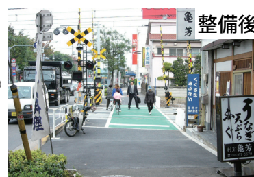
踏切道の拡幅例
