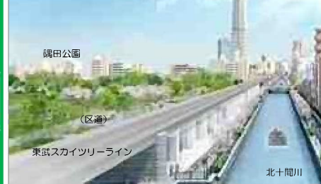
枕橋側から小梅橋方面を望む
