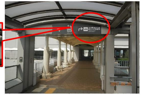
② 連絡通路 天井部
