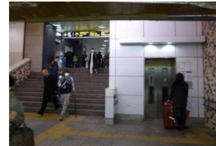
段差解消のための昇降機（新宿駅） 【乗換ルートのバリアフリー化】
