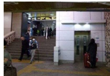
段差解消のための昇降機（新宿駅） 【乗換ルートのバリアフリー化】
