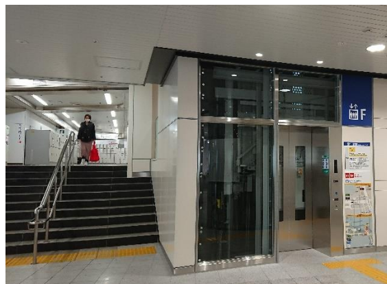
新規EV設置
