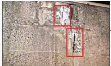
擁壁のコンクリート剥離・鉄筋腐食
