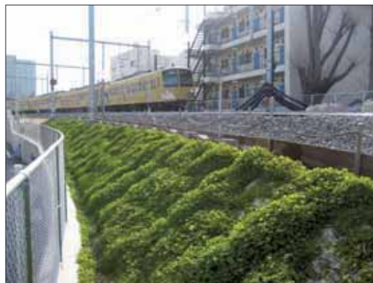
◇鉄道敷内の盛土法面の緑化 (西武池袋線)
