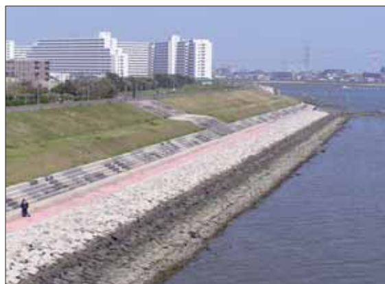
◇緑化された緩傾斜型堤防 (旧江戸川：江戸川区)
