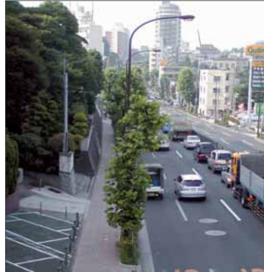
◇無電柱化の整備前（左）と整備後（右） （環七通り：世田谷区）
