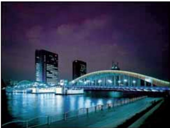
◇東京都選定歴史的建造物に選定されている勝鬨橋 （晴海通り：中央区）
