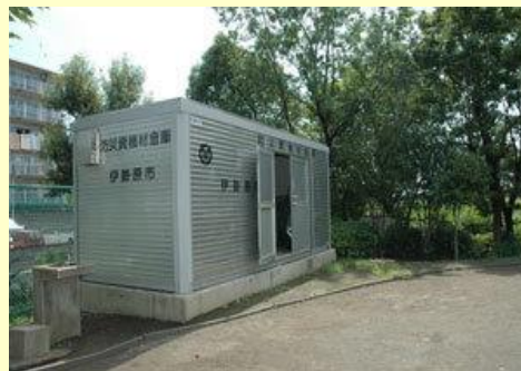
防災対応 (例：防災備蓄倉庫)
