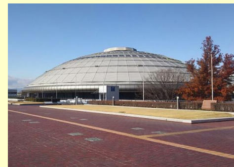
暑さ対策 (例：屋根付き運動施設)
