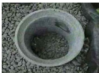
雨水浸透ます
