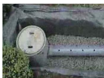
雨水浸透トレンチ
