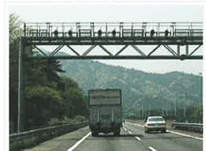
名神高速に設置されているNシステム
