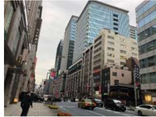
建物名：コレド室町1・2・3 所在地：中央区日本橋2丁目 竣工年：平成22年10月 (コレド1) ：平成26年3月 (コレド2・3)
