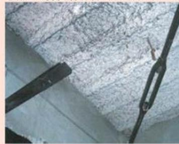
石綿含有吹付けロックウールとは、工場で生産された人工鉱物繊維であるロックウールに、セメント等の結合材を重量で30%~40%程度混入するほか、アスベストを含んで吹付け施工されたものです。
