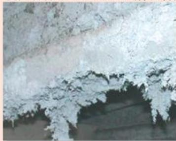
吹付けアスベストとは、アスベストにセメント等の結合材を重量で30%~40%程度混入し、水を加えて柱や天井・壁などに吹付け施工されたものです。
