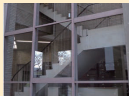
写真8 硬化性パテで固定されたはめ殺し窓
