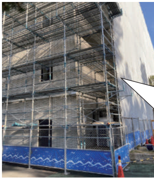
仮設足場の設置
