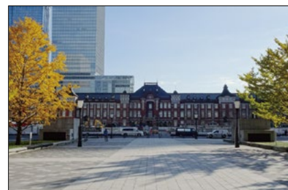
東京駅丸の内駅舎（外壁色10R4.0/6.0 彩度:6）
