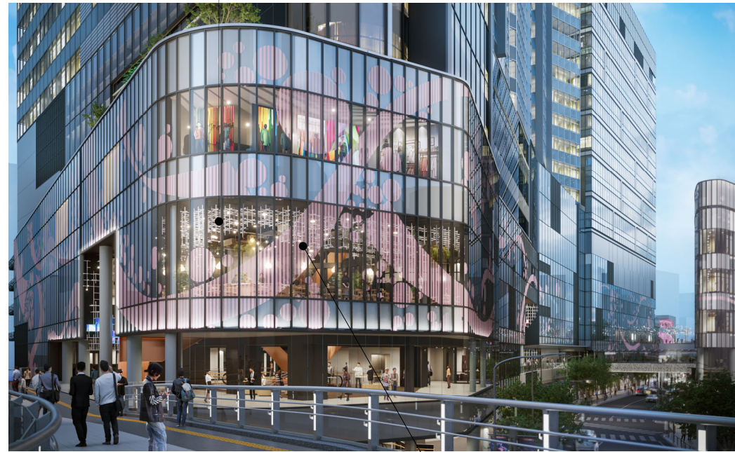
①【西口国道デッキ(2Fレベル)よりA街区アーバン・コアを望む】
