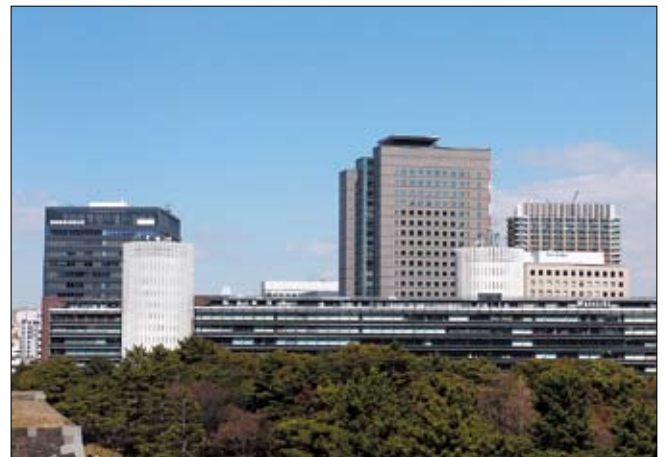
街並みの現況例（千代田区一ツ橋周辺）
