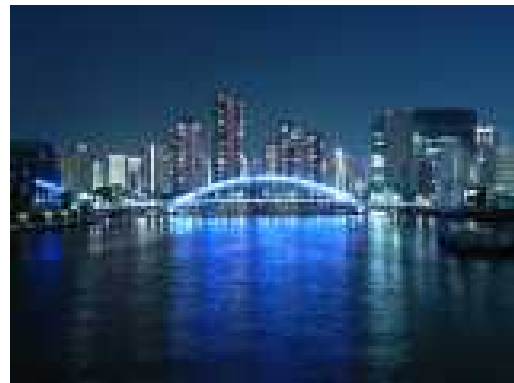
隅田川橋梁のライトアップ
