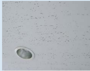
■天井材 例) 石綿含有吸音板
