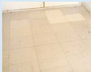
■床材 例) 石綿含有ビニル床タイル
