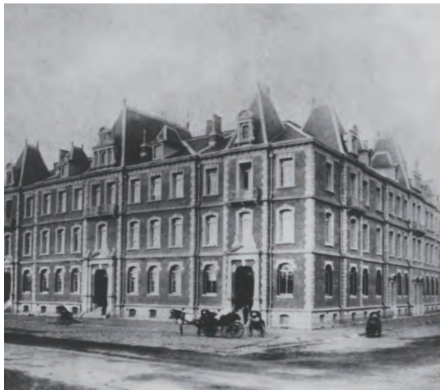
三菱一号館 三菱一号館美術館所蔵 三菱一号館は、ジョサイア・コンドルの代表作の1つで、煉瓦造3階建の事務所建築として明治27(1894)年に丸の内に完成し、丸の内の赤レンガ建築の発端となりました。昭和43(1968)年に老朽化により解体されましたが、平成22(2010)年に「三菱一号館美術館」として復元されました。
