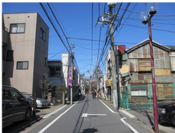
④拡幅整備が進みつつある補助 227 号線
