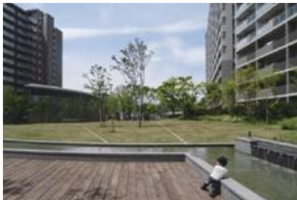
多摩市諏訪2丁目住宅のマンション建替え事業
