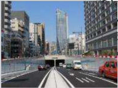
環状2号線(新橋～虎ノ門)
