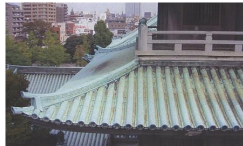
改修前屋根部（届出資料より）
