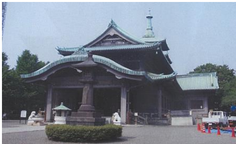
改修前外観（届出資料より）
