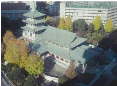
改修後外観（届出資料より）
