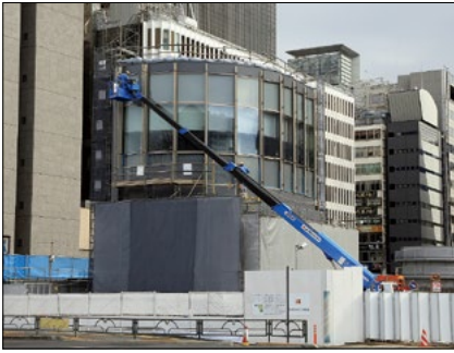
モックアップによるガラス外装の色評価
