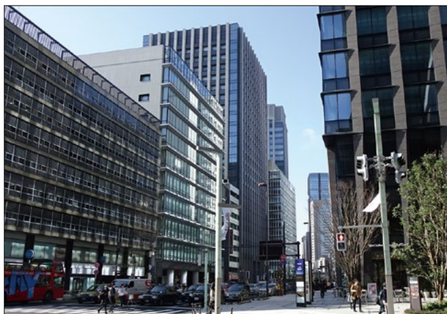
大規模建築物等の現況（中央区京橋周辺）
