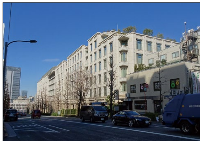
大規模建築物等の現況（品川区北品川周辺）
