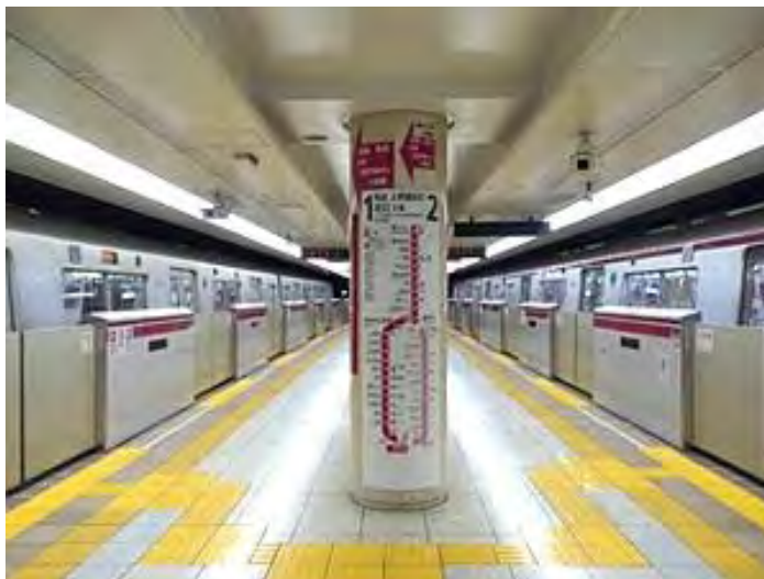
<ホームドアの設置>
