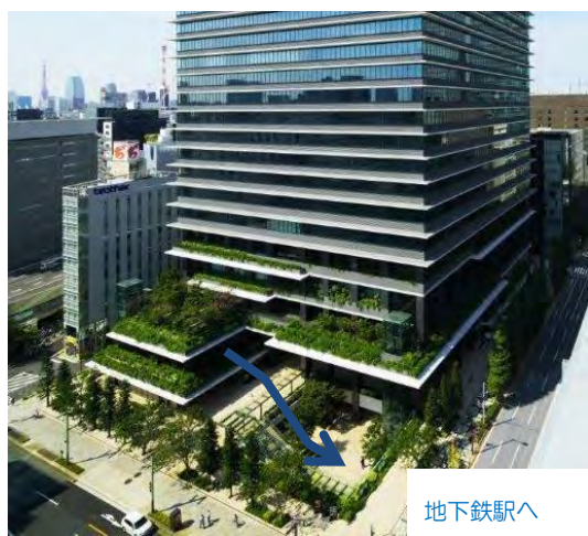
＜地下駅前広場の整備例＞ (中央区 京橋東京スクエアガーデン)
