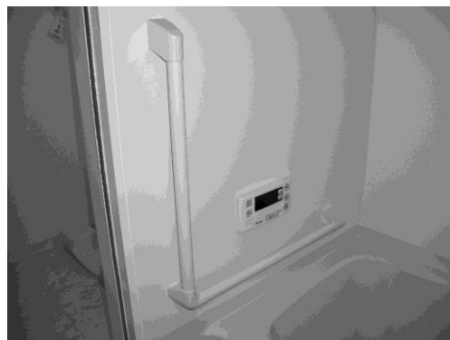
d 手すりの設置例
