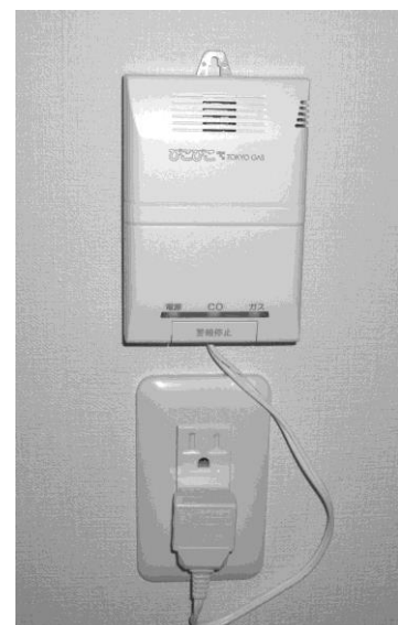
d ガス漏れ検知器
