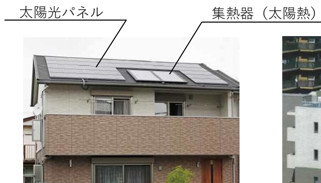
戸建て住宅への設置
