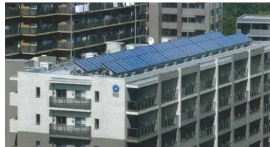
集合住宅への設置
