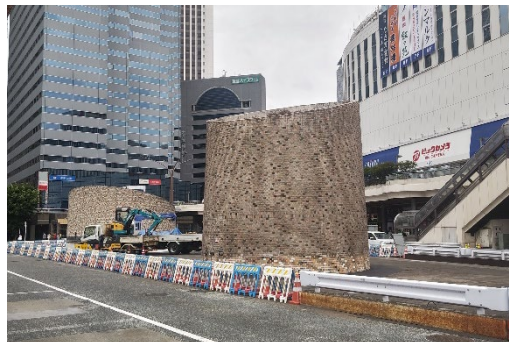
写真 2 地上の換気口（吸気口） (新宿駅西口)
