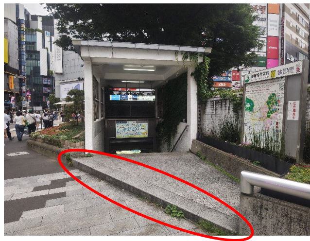
写真 13 地下街出入口のマウントアップ（新宿駅東口）
