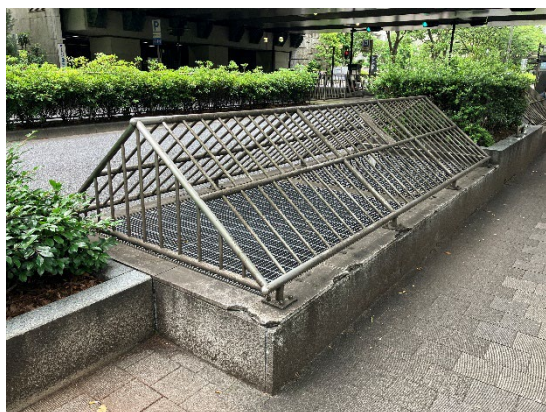
写真 15 換気口の立上げ (新宿西口)
