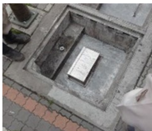
写真 21 浸水防止機（換気口からの浸水を防止）
