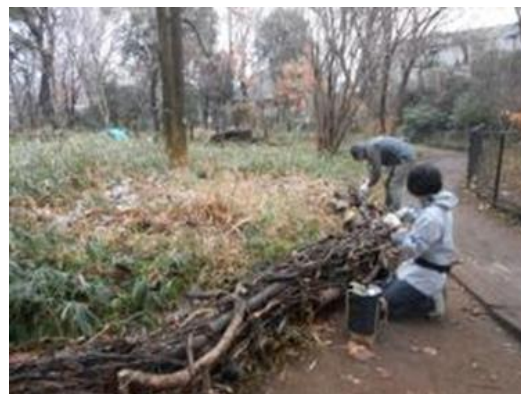
そだ柵設置の様子
