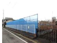
農薬飛散防止施設
