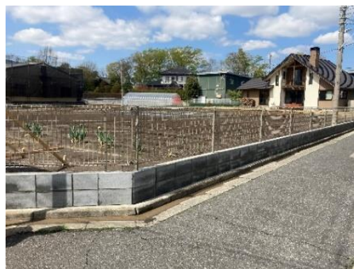
土留め、フェンス
