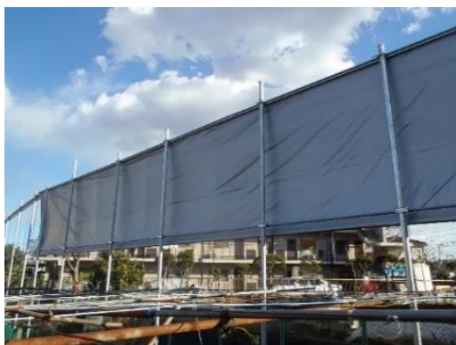
農薬飛散防止施設
