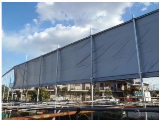
農薬飛散防止施設
