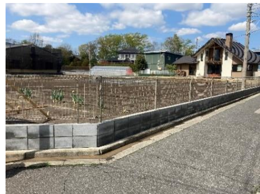
土留め、フェンス
