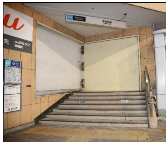
写真 20 地下街出入口の止水板（左）及び防水扉（右）
