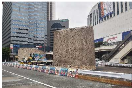
写真 2 地上の換気口（吸気口） (新宿駅西口)
