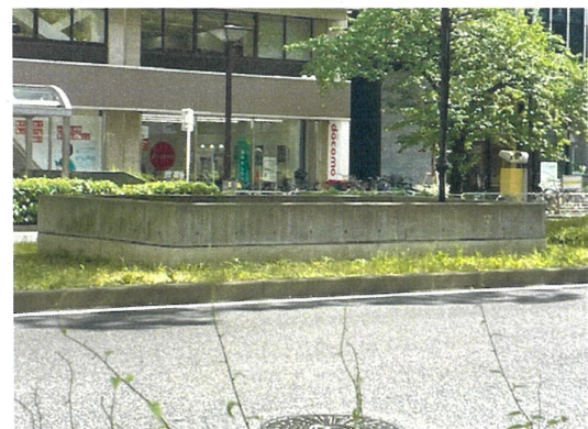
写真 14 平成 20 年の豪雨を契機に入口階段を 2 段嵩上げ（左） 道路中央の換気口も 60cm 程度嵩上げ（右） （名古屋市の取組）
